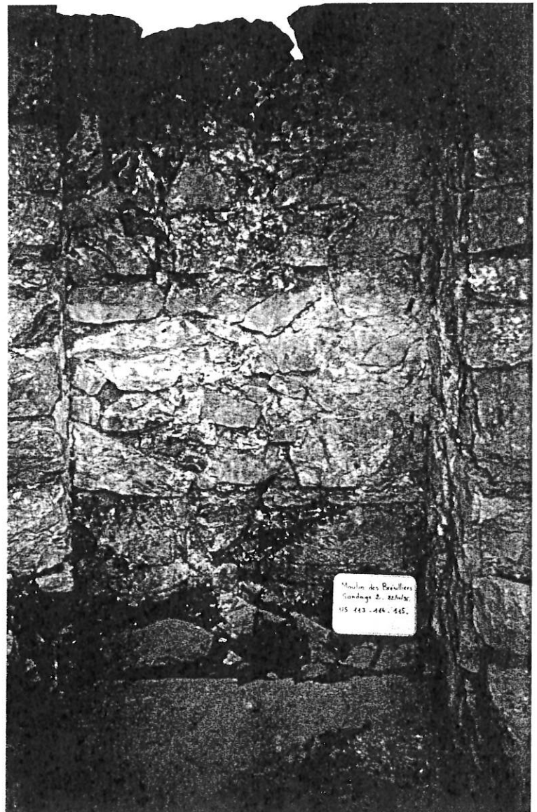
M 115 Vu de l'intérieur
