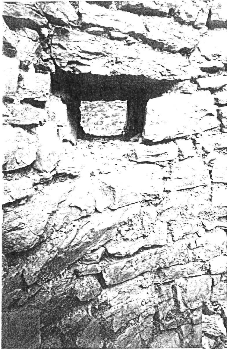
Conduit d'aération Nord-Est
