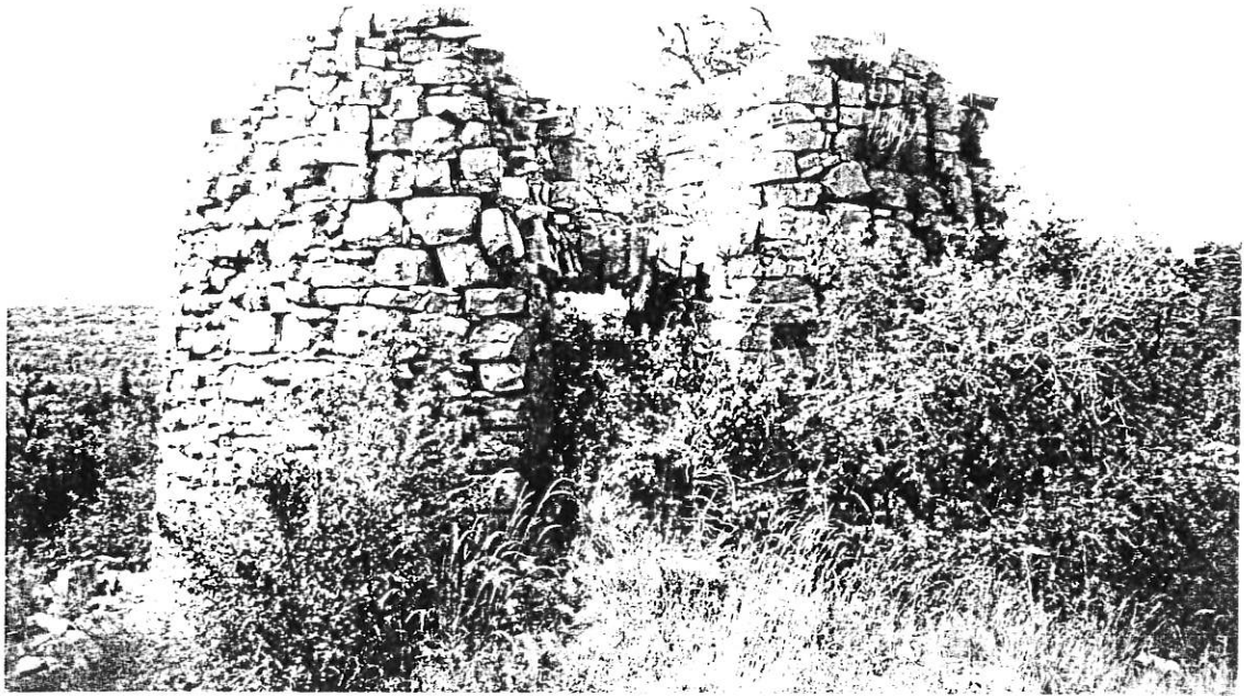
Moulin des Brésilliers. Vue générale du Sud avant dégagement
