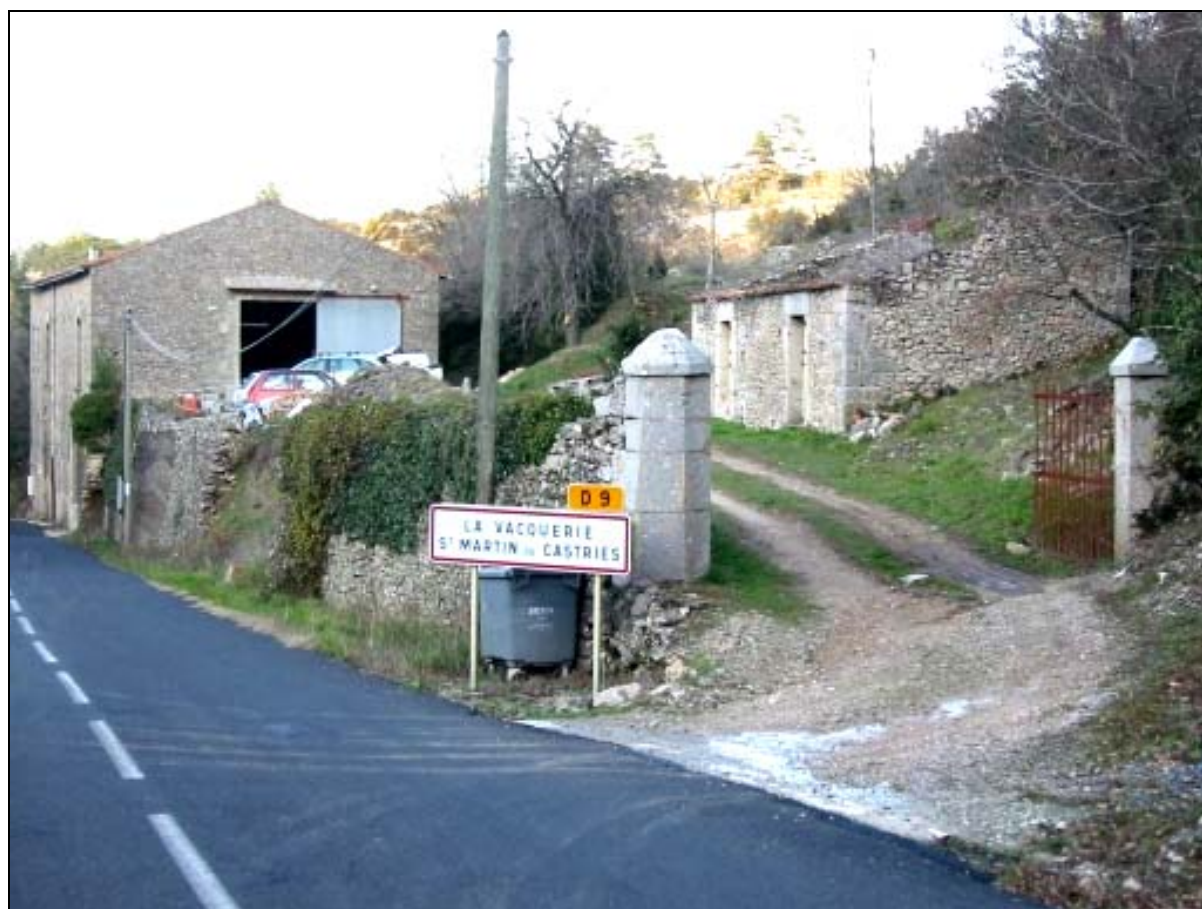
Situation de la laiterie, à l'entrée sud du village de La Vacquerie.
