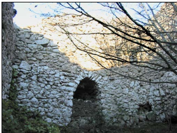
Intérieur : mur nord.
