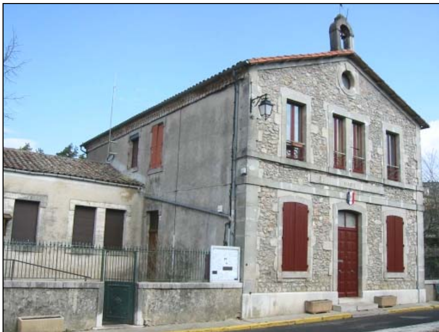
La mairie, et l'ancienne cour de l'école des garçons, sur la gauche (la classe a été transformée en petite salle des fêtes).
