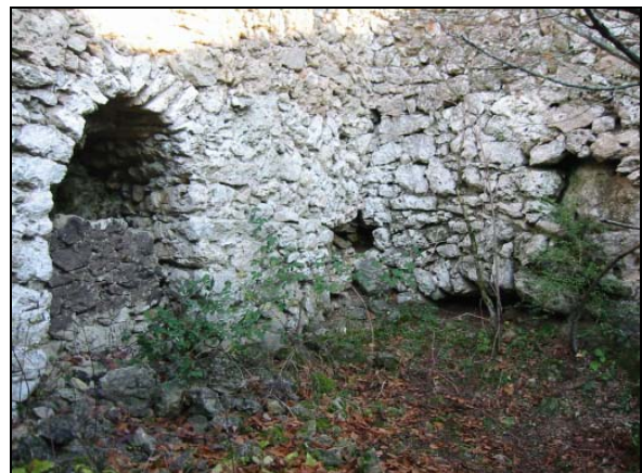
Intérieur : angle nord-est.
