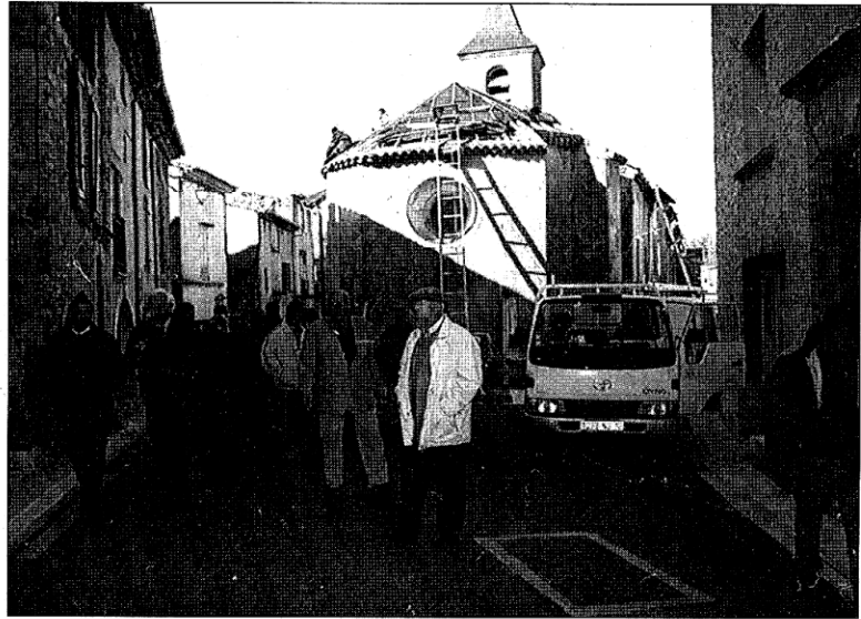
Une promenade inaugurale sur les différents lieux rénovés au cœur du village.
