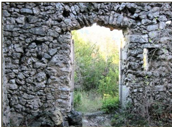
Intérieur : entrée à l'ouest.
