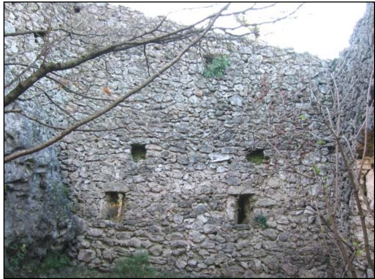
Intérieur : mur sud.
