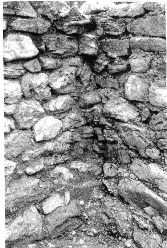
Figure 11. Chaînage du mur occidental primitif avec le mur septentrional initial, vue depuis le nord-est
