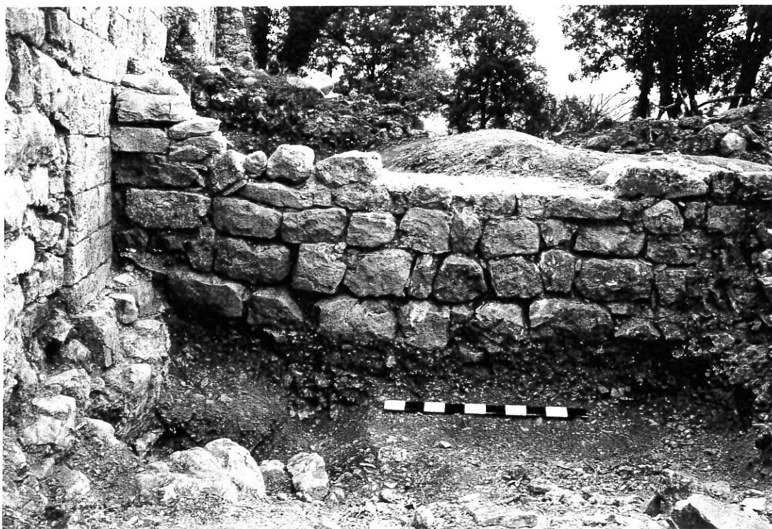
Figure 14. Contact entre un mur antérieur à l'église et le mur roman au moyen d'un mur « tampon », vue depuis l'ouest
