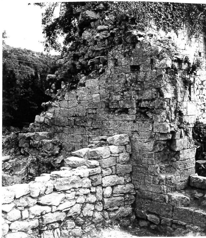
Figure 12. Contact du mur nord du bâtiment primitif avec l'église romane postérieure au moyen d'un mur « tampon », vue depuis le sud-ouest
